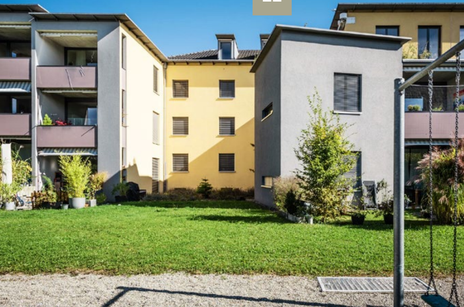
Schaffhauserstrasse 155–165, Totalsanierung 2003/04 mit grundrissvergrößernden Anbauten auf der Gartenseite.
