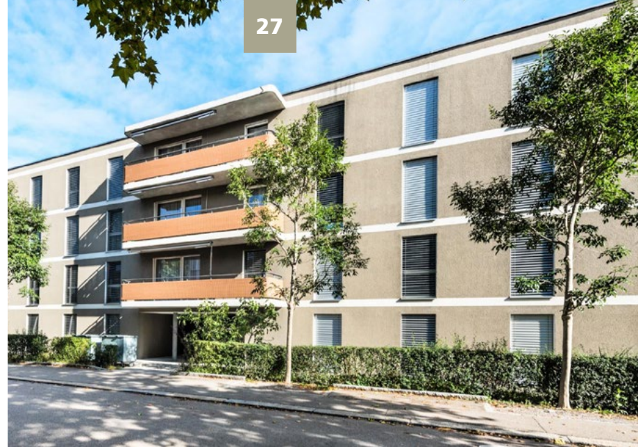
Ersatzbauten Obere Schöntalstrasse 20–22, Jahr 2010.
