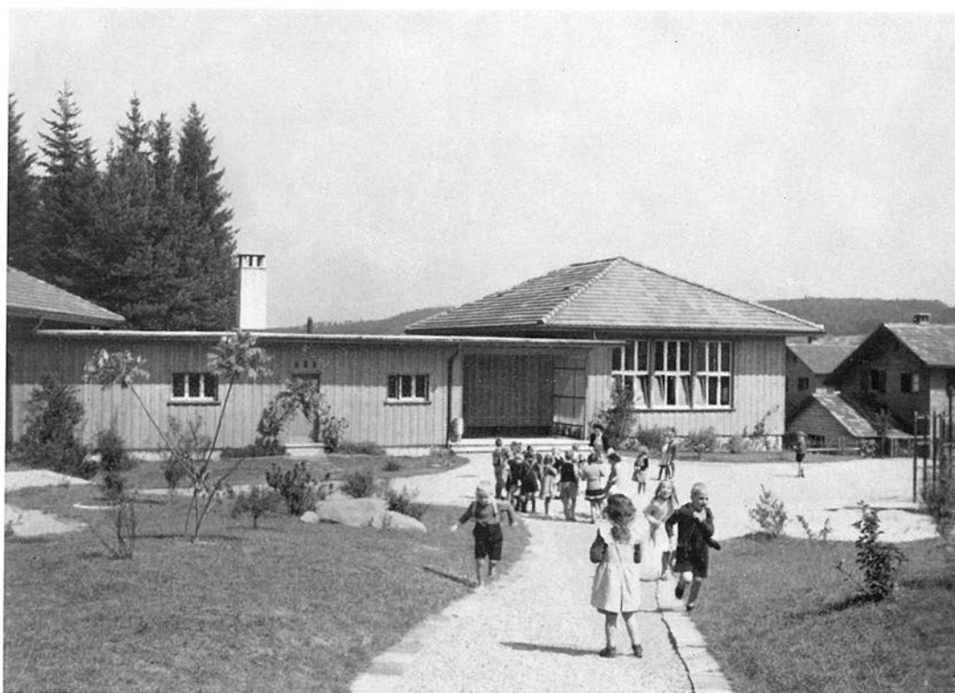
Abb. 23. Kindergarten Weiherhöhe in Holzkonstruktion mit zwei Klassenzimmern. Baujahr 1948 (Architekturbüro Kellermüller & Hofmann)
