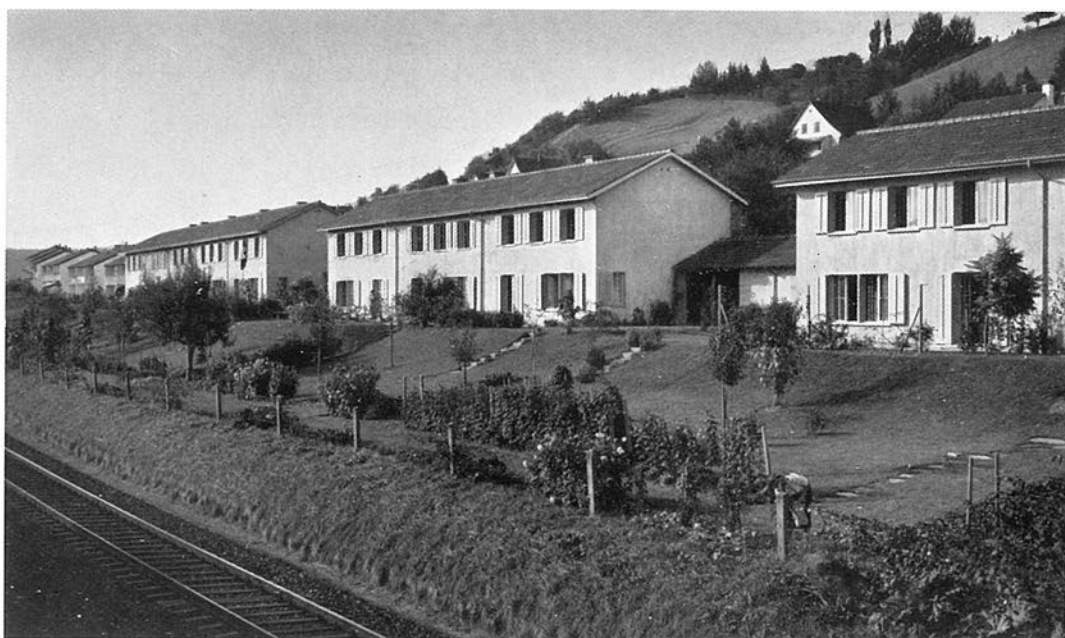
Abb. 19. Teilansicht der ersten Bauetappe der Wohnkolonie Winzerstraße. Baujahre: 1947/48 (Architekturbüro Kellermüller & Hofmann)
