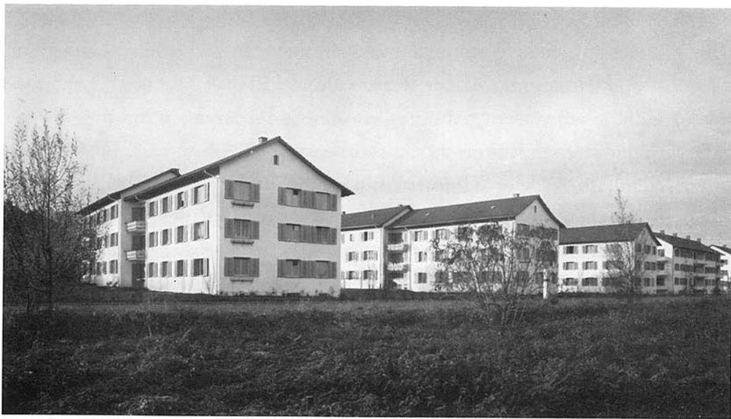
Abb. 26. Dreigeschossige Mehrfamilienhäuser mit 36 Wohnungen am Schiltwiesenweg, Oberwinterthur. Baujahr: 1950 (Architekt: Hans Hohloch)
