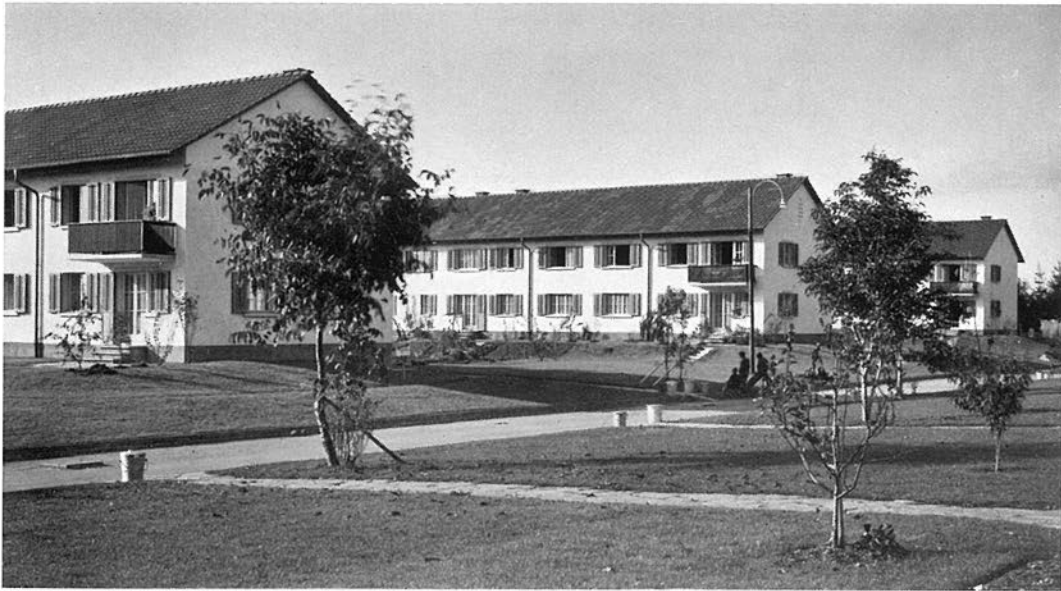
Abb. 25. Wohnkolonie Grubenstraße, zweite Bauetappe (1950), mit 40 Wohnungen in zweigeschossigen Mehrfamilienhäusern (Architekt Eugen Schmid)
