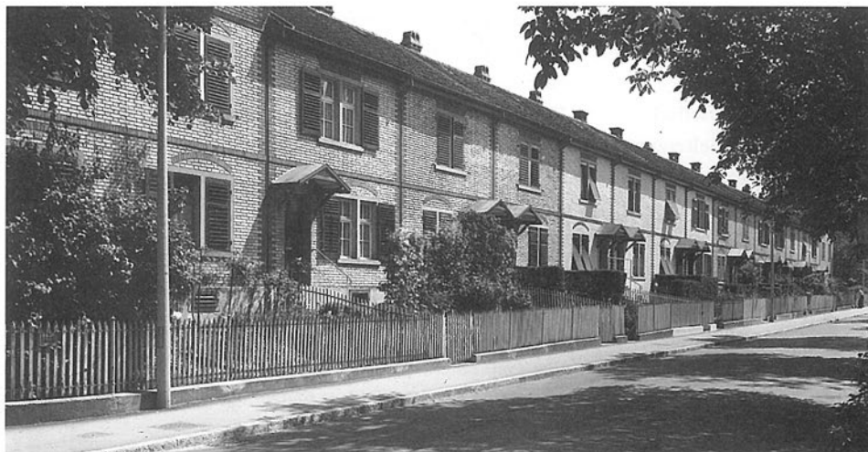
14 Reihen- und 2 Eckhäuser an der Unteren Vogelsang- strasse, erstellt 1891/92.
