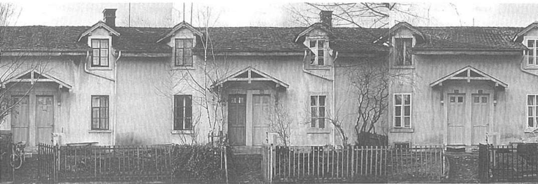
Ansicht von sechs Jägerhäusern vor Beginn der Restaurierung.
