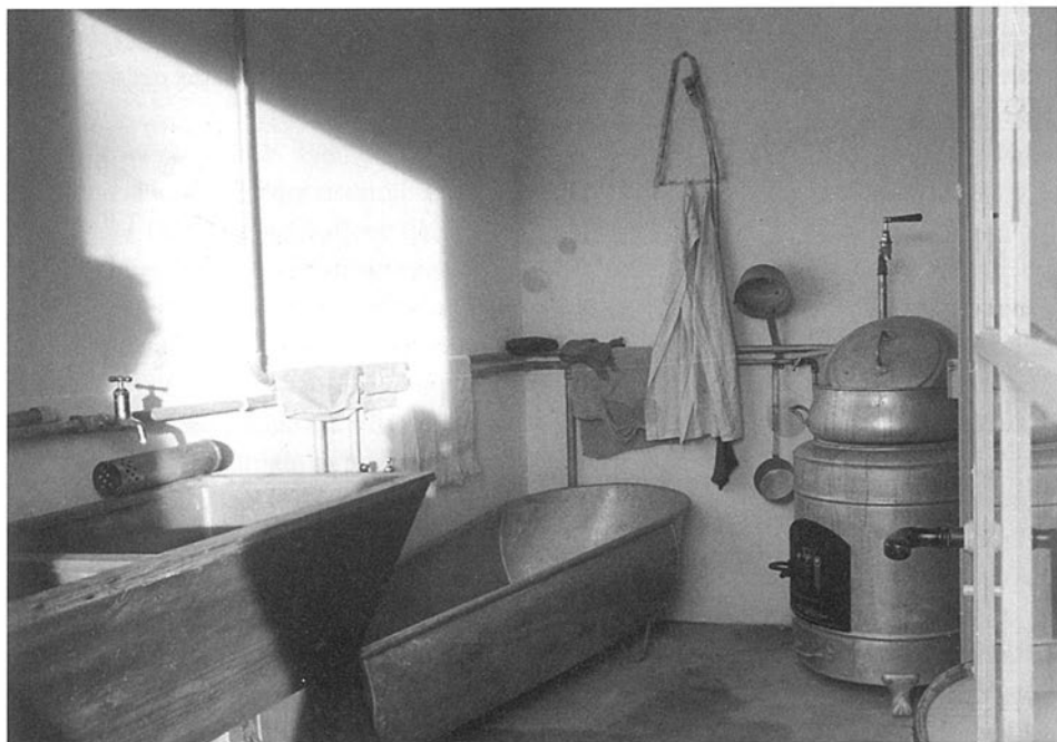
Waschküche mit Waschkafen und Badewanne, in einer Siedlung aus den 40er Jahren.
